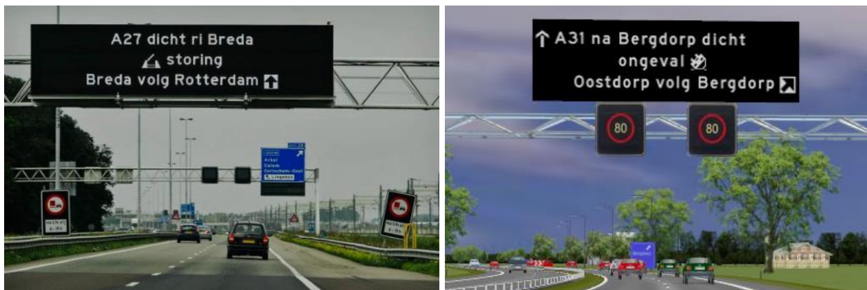
Figuur 2. Een rijbaanbrede DRIP die weggebruikers informeert dat zij van hun route moeten afwijken: een voorbeeld uit de praktijk (links) en in de rijsimulator (rechts).
