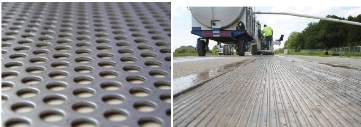
figuur 2: links een berekende en rechts een gefreesde textuur voor geluidreductie
