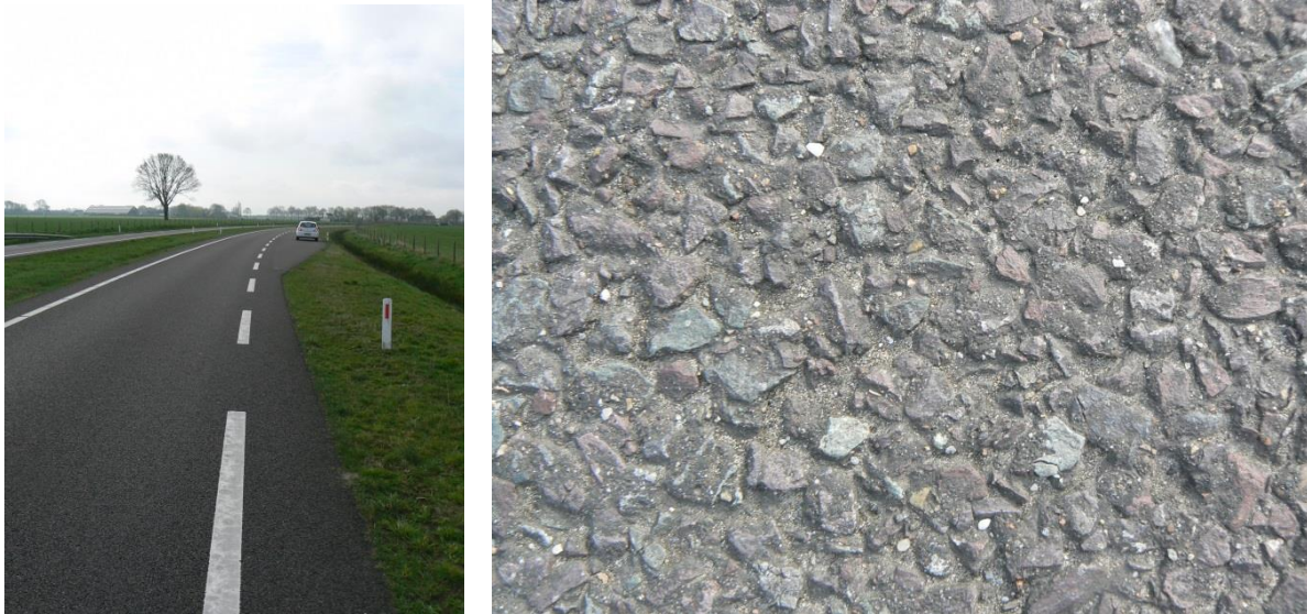
Figuur 2. Links, overzicht van SMA proefvak Zeddum, rechts detail van open structuur
