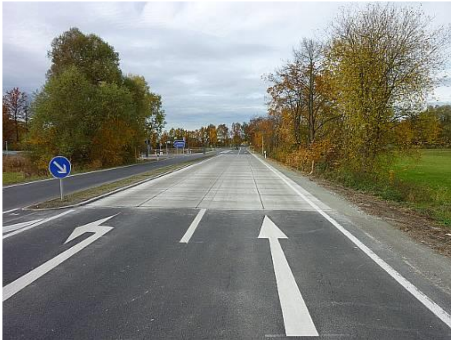
Afb. 1 Voorbeeld gerealiseerd werk in whitetopping
