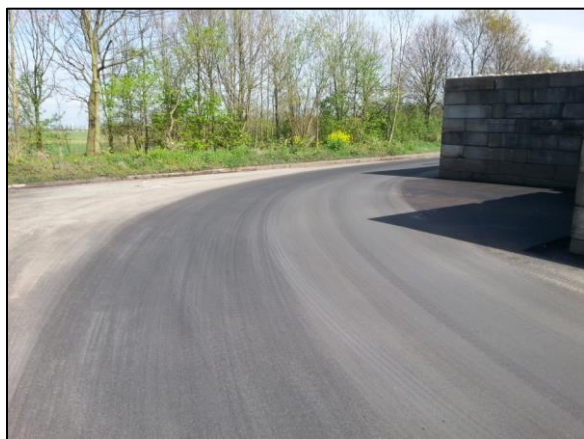
Foto 5A en 5B: Praktijkproef - KonwéCity aangelegd in haakse bocht asfaltcentrale
