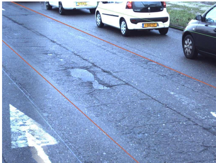
Figuur 4; Schade geclassificeerd als urgent
