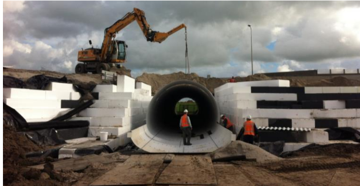
Figuur 4 Monteren van de gegolfde staalplaten van de fietstunnel onder de N222
