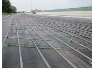
Figuur 2. Wapening van de DGB-verharding in een proefvak op de E17 bij Gent.
