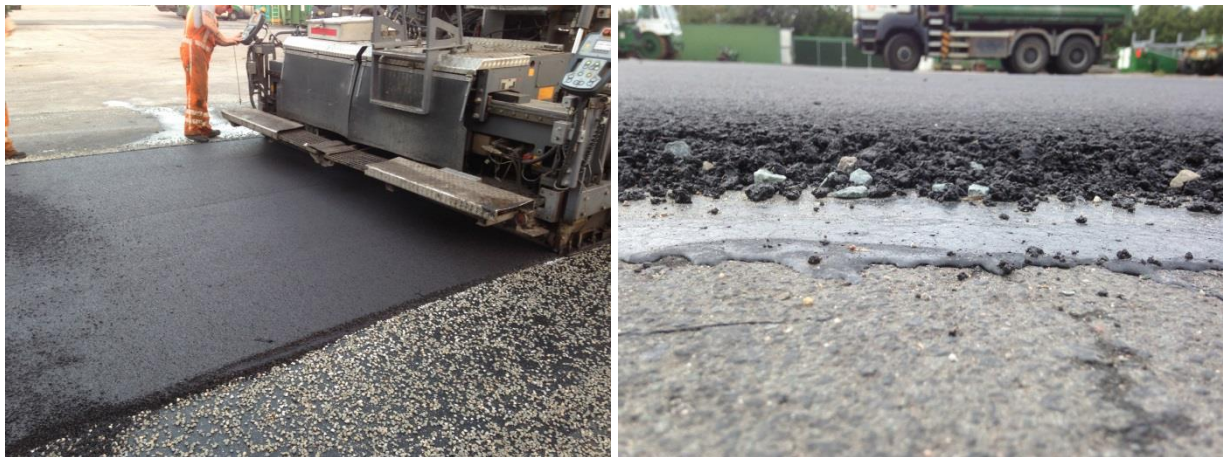
Figuur 7 en 8: Aanbrengen tussenlaag voorbereidingsvak en doorsnede dunne tussenlaag.
