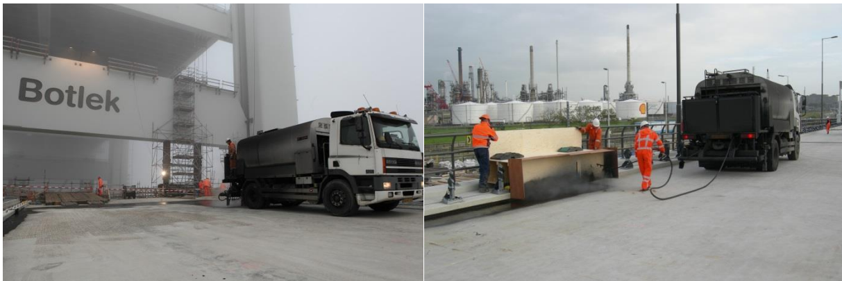
Figuur 9 en 10: Aanbrengen hechtlaag en zelfrijdendscherm.
