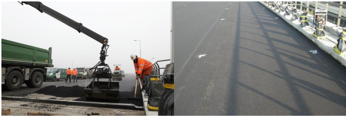
Figuur 11 en 12: Aanbrengen asfaltonderlaag en uitvullaag gereed.
