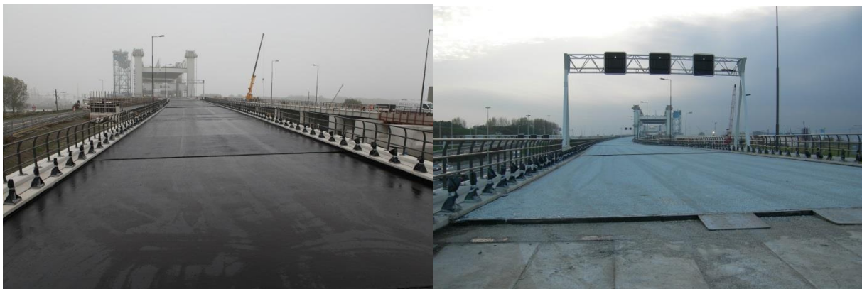
Figuur 13 en 14: Aangebracht bitumineus membraan en aanbrug na afstrooien membraan.
