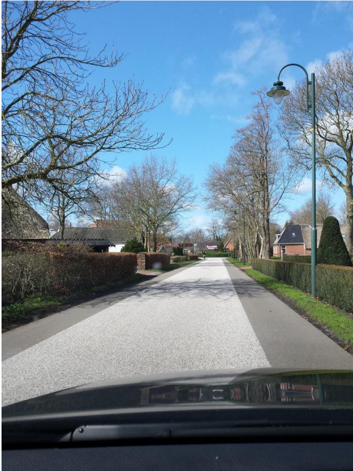
Figuur 9 Lichtgekleurd wegdek bereikt met een oppervlakbehandeling.
