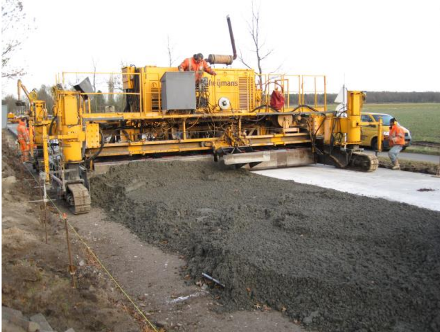
Figuur 4: Aanleg van de N277 met vezelmixbeton
