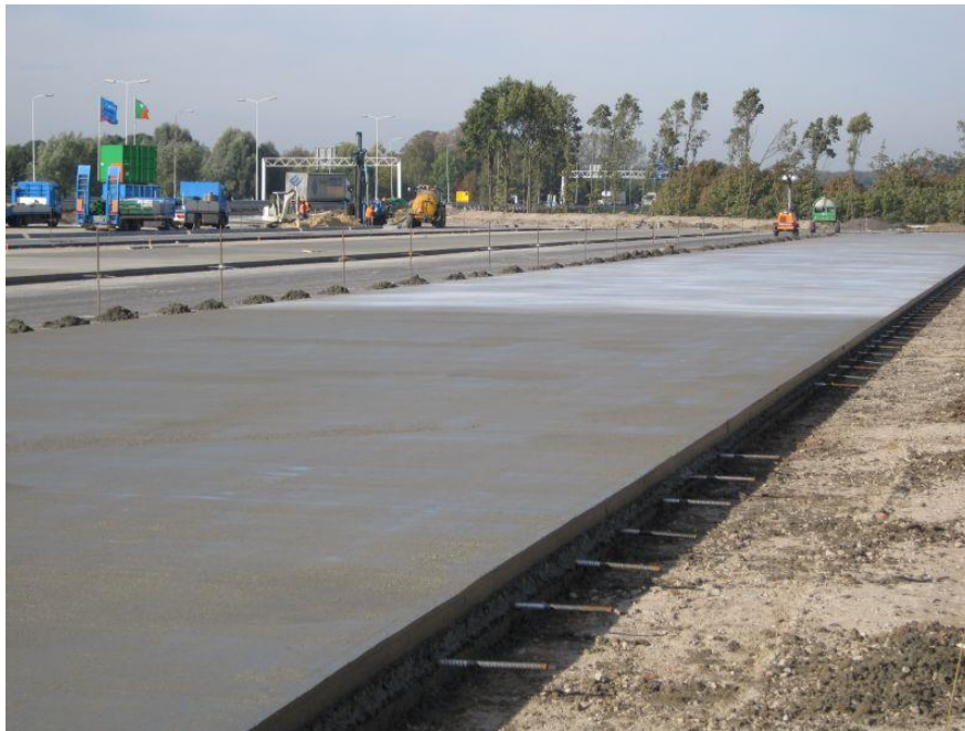
Figuur 1. Aanleg van vrachtwagenparkeerplaatsen langs de A76 bij Venlo
