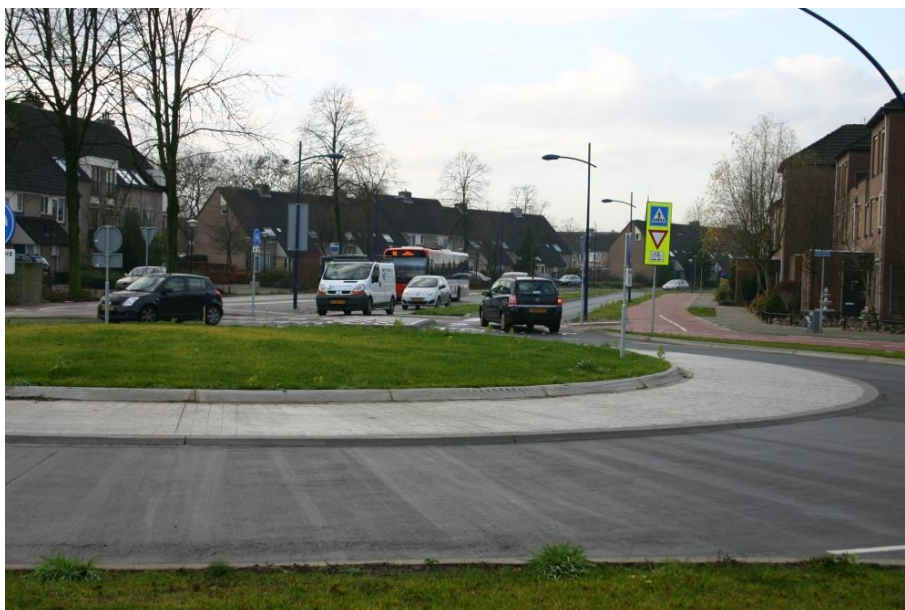
Figuur 5: Binnenstedelijke rotonde in vezelmixbeton te Veghel
