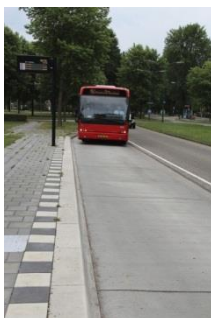
Foto 6: Bushalte in ongewapend beton
