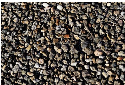
Foto: conditie oorspronkelijk ZOAB A67 (steenslag in de ZOAB is Morene of Nederlandse Steenslag)
