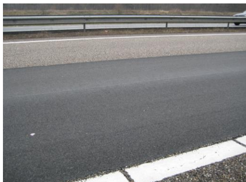
Foto a: ZOEAB+ behandelde ZOAB – (inspectie april 2013, een half jaar na aanleg) Foto b: onbehandelde ZOAB in hetzelfde wegvak (textuurschade in het spoor is duidelijk)
