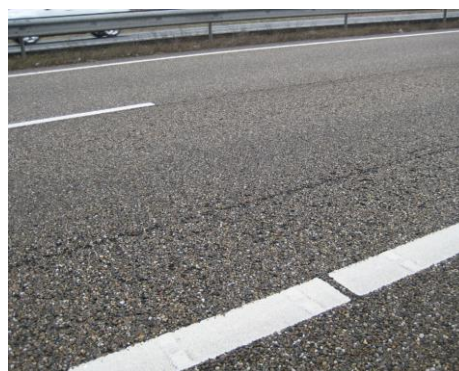
Foto a: ZOEAB+ behandelde ZOAB – (inspectie april 2013, een half jaar na aanleg) Foto b: onbehandelde ZOAB in hetzelfde wegvak (textuurschade in het spoor is duidelijk)
