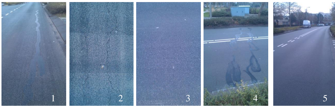
Afbeelding 7: foto's visuele inspectie 2014
