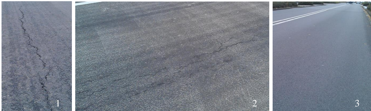
Afbeelding 6: langsscheuren en aanwezigheid slurry KonwéClear C (1 en 2) en algemene staat van KonwéClear S (3) in 2012
