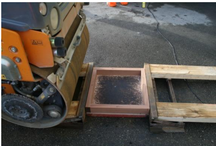
Figuur 9: Opstelling plaatverdichting met miniwals(HAMM HD10)
