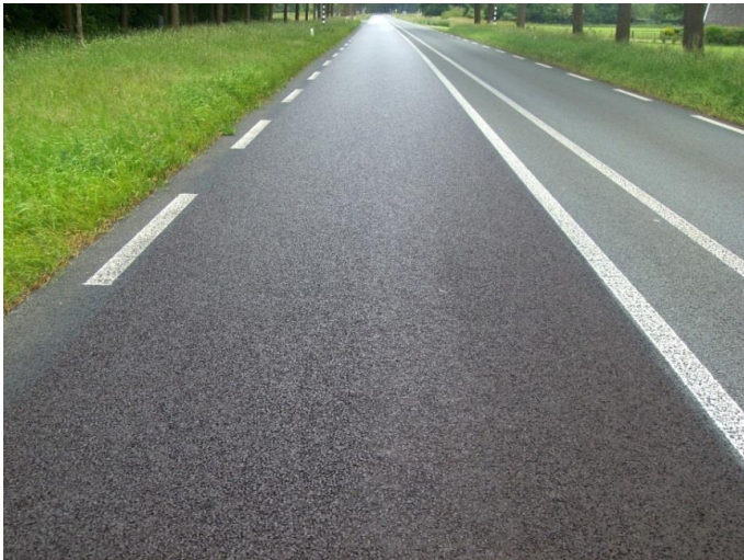
Foto 3, N346 – LVO-maatregel op Provinciale weg, juni 2013.
