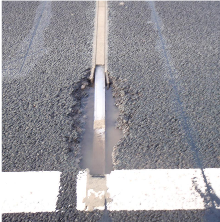
Figuur 1. Een WIM-sensor in het wegoppervlak geeft vaak te snel aanleiding tot schade aan wegdek en sensor.
