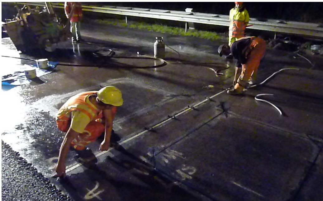
Figuur 3. Inbouw van een rijstrook brede WIM-FO sensor in de tussenlaag van een snelweg. De sensor ligt verdiept in de tussenlaag.
