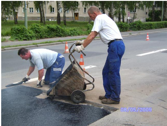
Berlijn: 2009 - GA met 20/30 PX Temp 206°C - manueel werk
