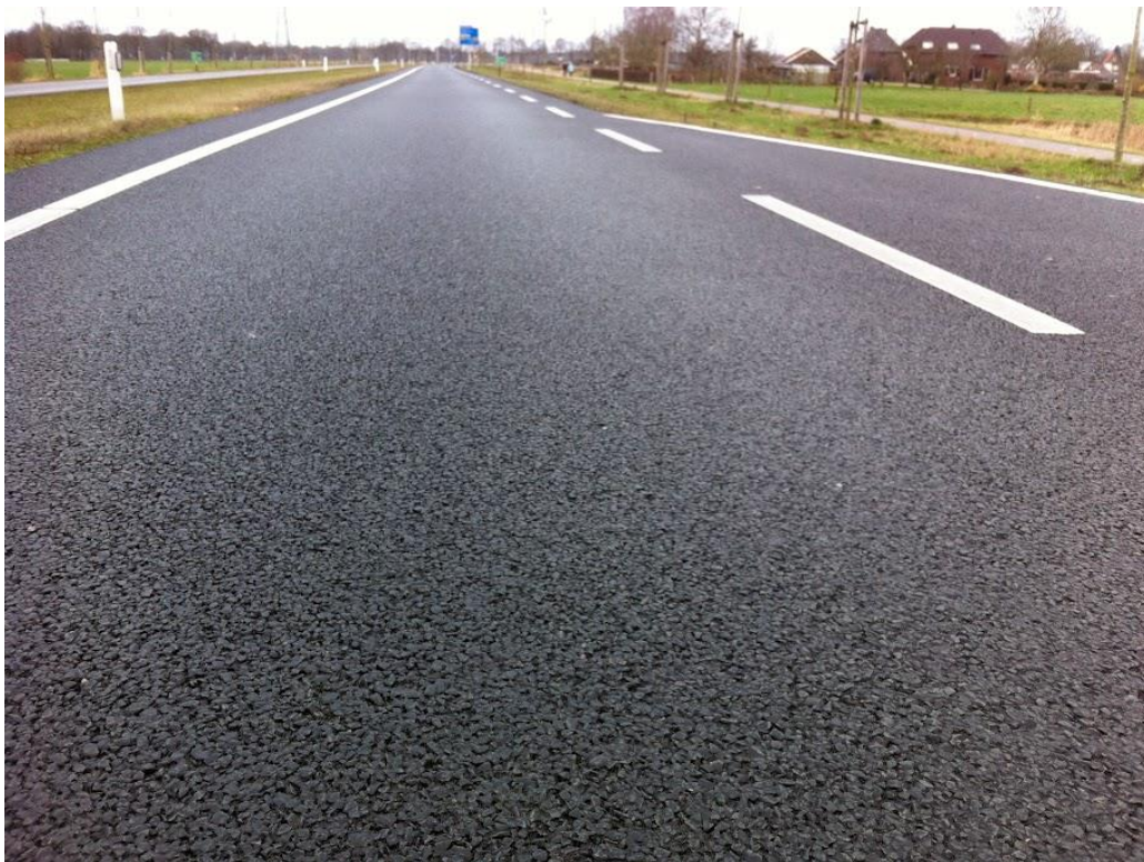
Proefvak LEAB-PA+ jan 2014: ruim 3 jaar na aanleg
